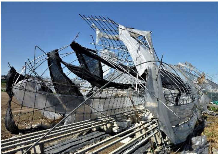
台風被害の様子
